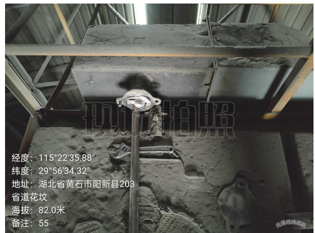
熟料库顶入库拉链机 DA055 有组织排放废气检测点位
