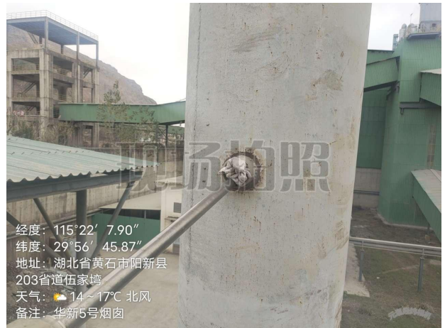
辅助原料破碎及运输 DA005 有组织排放废气检测点位
