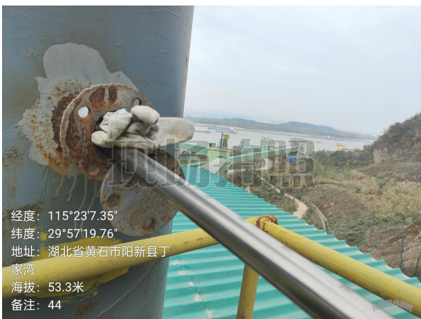
码头 2#泊位原煤进厂输送皮带 DA044 有组织排放废气检测点位
