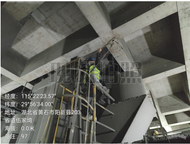
水泥库底 2 输送 DA097 有组织排放废气检测点位
