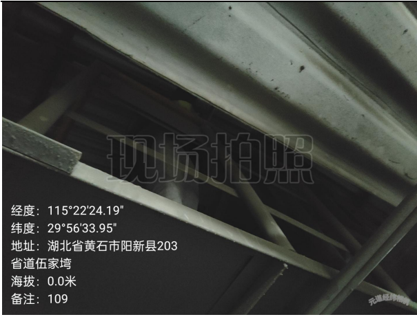
水泥库底 3 输送 DA109 有组织排放废气检测点位
